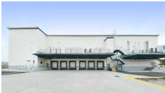
【新棟外観風景】
